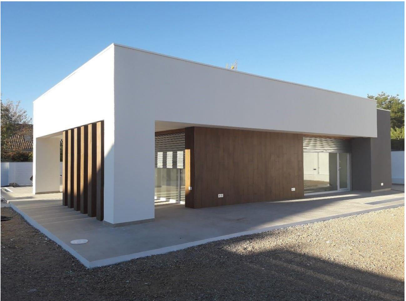
Son varios los revestimientos que se usan actualmente como capa de acabado de un SATE, los más utilizados son los revocos continuos de diferente naturaleza (acrílica, silano-siloxanos, hidráulicos de cemento o cal, silicato), todos ellos presentan una amplia gama de colores y texturas.
