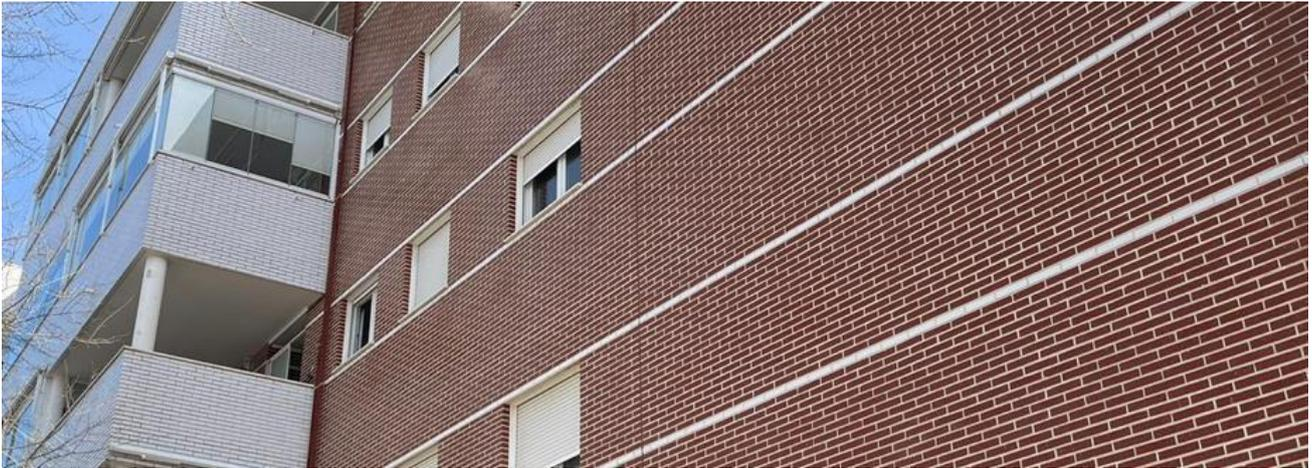
Como sabemos la interacción pieza-mortero se debe a un proceso físico mecánico donde el mortero en estado plástico aplicado sobre las piezas facilita que el cemento penetre en los poros del ladrillo.
