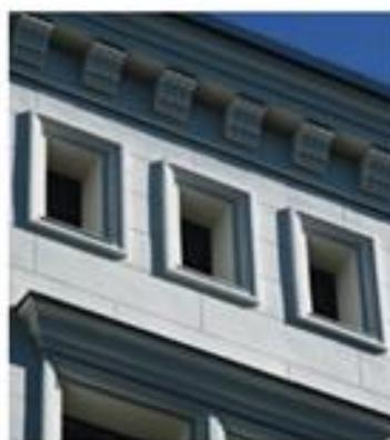
Configuración básica de un elemento ornamental lineal sobre SATE, sobre el mortero armadura con malla: 1) adhesivo, 2) moldura, 3) y 4) acabados según requerimientos de los fabricantes. La fijación mecánica (no representada) dependerá principalmente del peso de la moldura.
