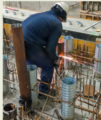
Las imágenes muestran el proceso llevado a cabo: una vez hormigonados los muros y encepados, se procede a la ejecución de la hincas desde la cota superior de los encepados.
